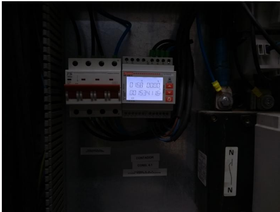
Figura 7: Analizador de red que mide el consumo global de uno de los cuadros
